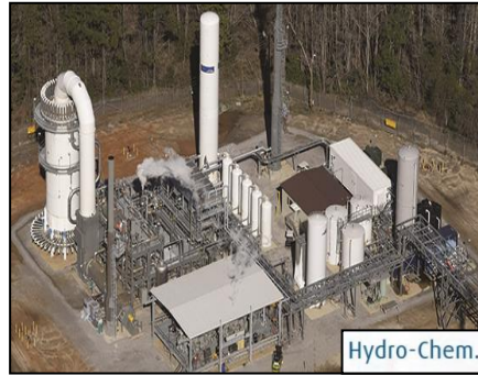
Stahlindustrie (USA) 11.000 Nm 3 /h
