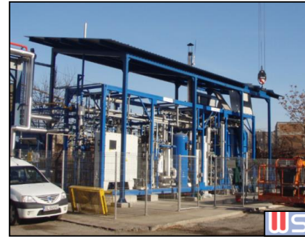
Stahlwerk (ROU) 300 Nm 3 /h
